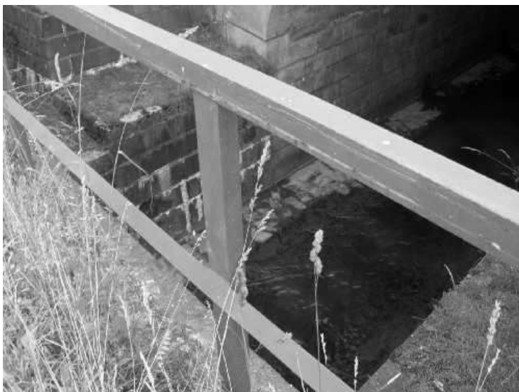
Degradace nátěru zábradlí.
