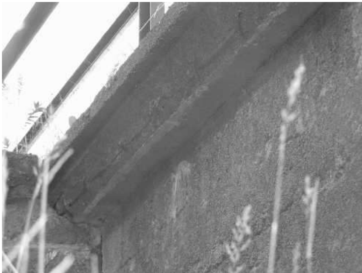
Rozpad betonu římsy nad levým křídlem OP2, obnažená korodující výztuž.
