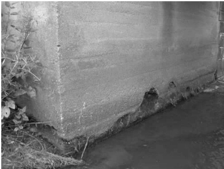
Poškozená omítka a degradace betonu v úrovni běžně zvýšené hladiny, kaverna hluboká cca 150 mm.
