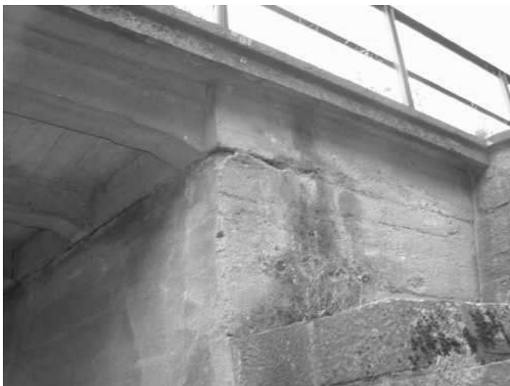
Zatékání na levý bok OP1 s výluhy.
