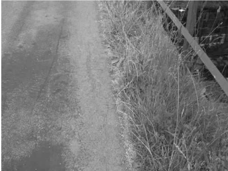
Trhliny ve vozovce u krajnice, vozovka převrstvena nad úroveň říms, krajnice zarostlá vegetací.
