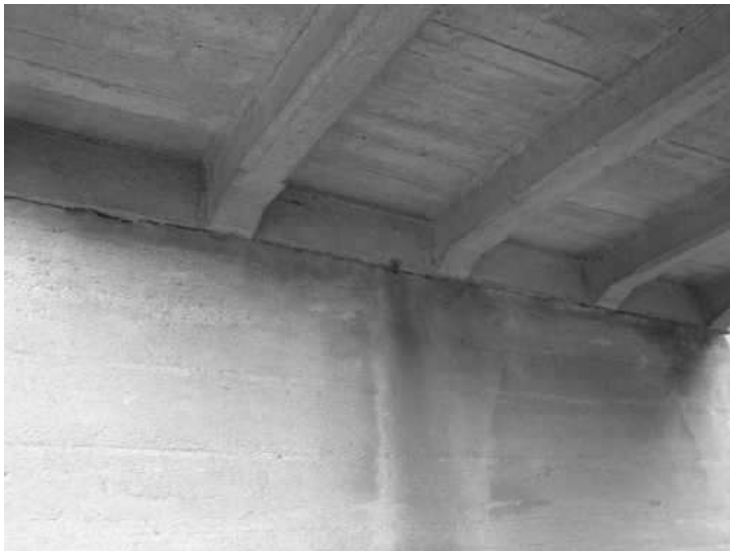
Stopy po zatékání na úložný práh OP1.
